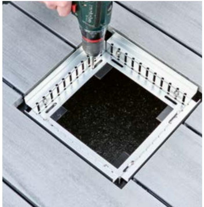
Revisionskasten einsetzen und an Windlastträger verschrauben
